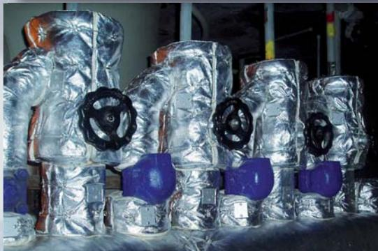
Als geeignete Alternative zur konventionellen Dämmung bietet sich die Matratzendämmung mit dem entscheidenden Vorteil der einfachen Handhabung im Zuge von De- und Remontagen an.
